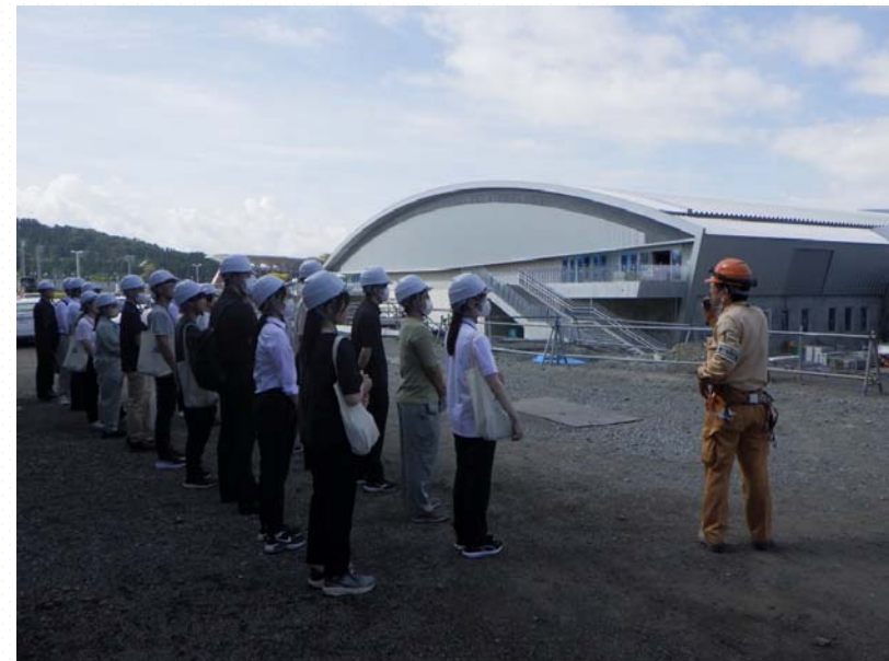
－現場見学（新青森県総合運動公園水泳場）－
