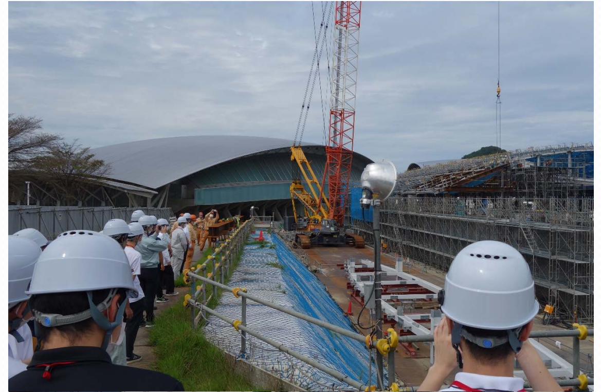
－現場見学（新青森県総合運動公園水泳場）－
