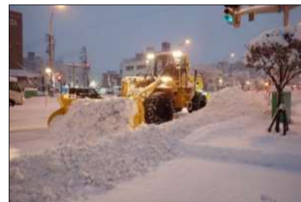
県道 18 号の除雪(青森市)
