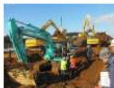
施工現場見学会
