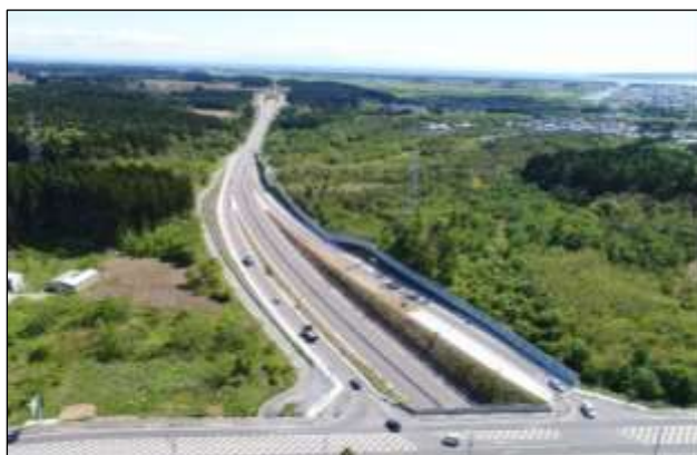
下北半島縦貫道路むつ南バイパス(むつ市)
