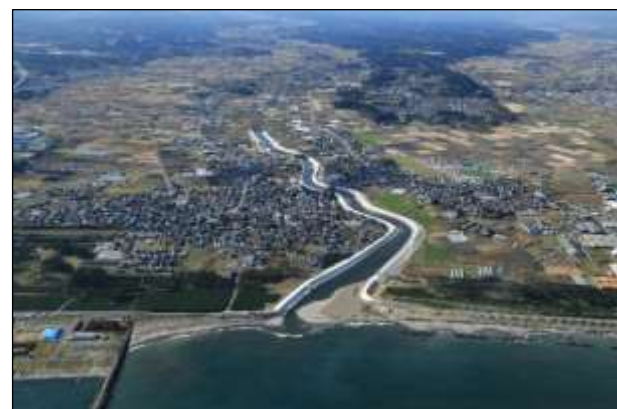
五戸川地震・高潮対策事業(八戸市)
