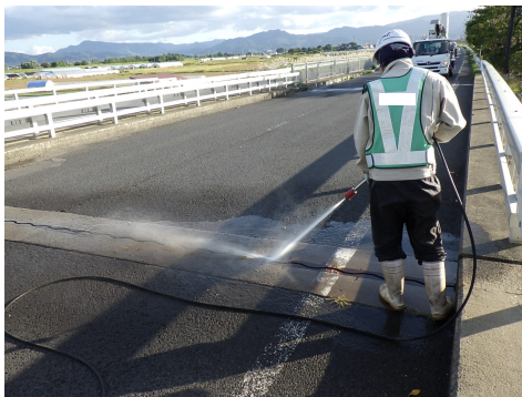
伸縮装置清掃
