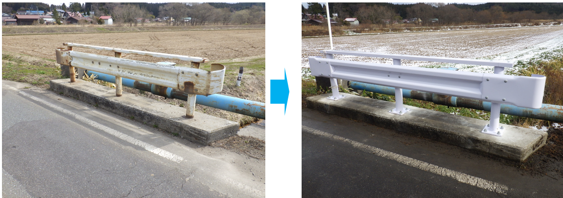
むつ尻屋崎線 木戸橋 高欄取替
