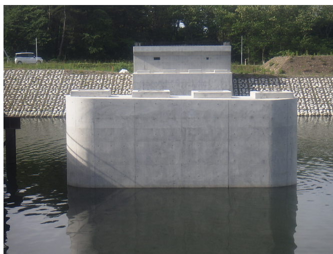
国道338号 高瀬川第二橋 橋脚施工完了
