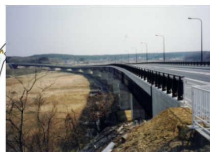
国道338号 猿子沢大橋
