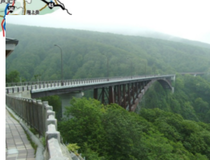
国道394号 城ヶ倉大橋
