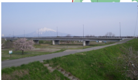
(主)大鰐浪岡線 アップル大橋
