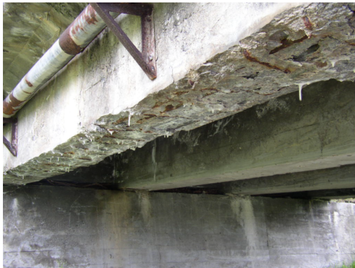
図 3 - 9 太平洋側の凍害を受けた橋梁
