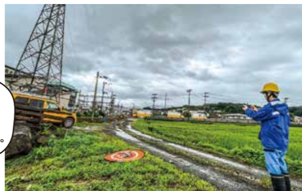
ドローンを活用して上空から設備状況を確認します
