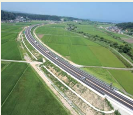
津軽自動車道の全景(青森河川国道事務所提供)
