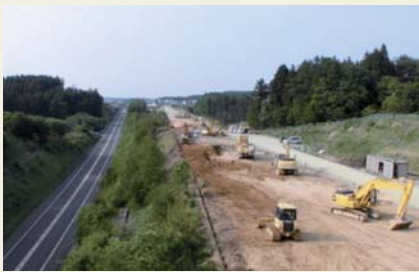
八戸環状線天久岱工区の工事状況
