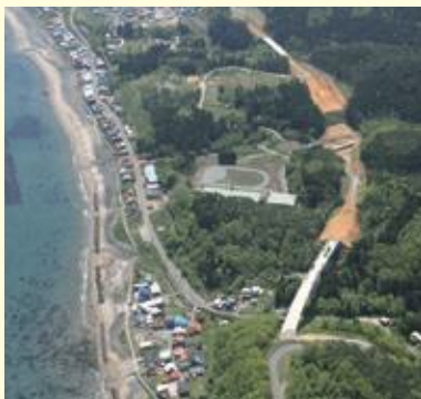
二枚橋バイパス工事の様子
