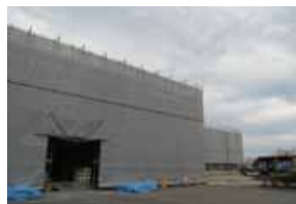
改修工事が進められている校舎 (旧八戸南高等学校校舎)
