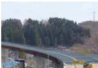
建設が進む中央町金矢線の道路工事
