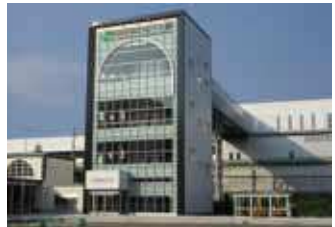
開業を控え、整備が進む奥津軽いまべつ駅
